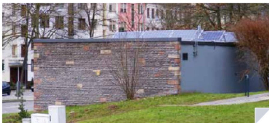
PV-Anlage mit saniertem Gebäude am Saarbrücker Ludwigskreisel
