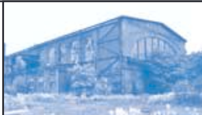
Burbacher Hütte, alte Halle
