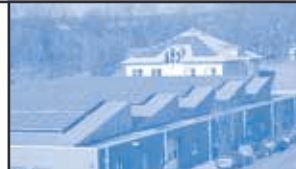
Tandem Photovoltaik + BHKW im SITZ
