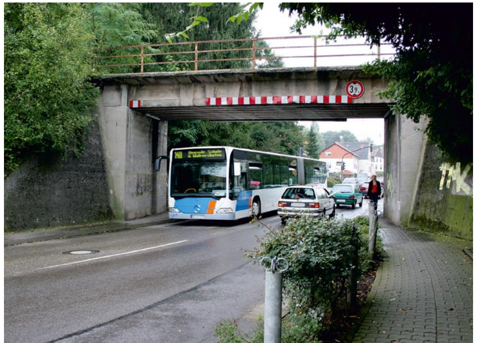
Brücke in Walpershofen wird auf 50 Meter erweitert
